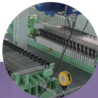
K-water OO净水厂
