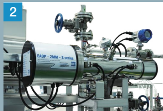
중압반응기 1.5~3kW 중압램프 설치 강도센서, 온도센서 적용
