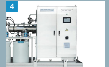
제어시스템 저압/중압 설비 운영 및 출력조절 운영모드 선택 현재 운전조건(유량, 온도, 자외선 강도 값 등) 모니터링
